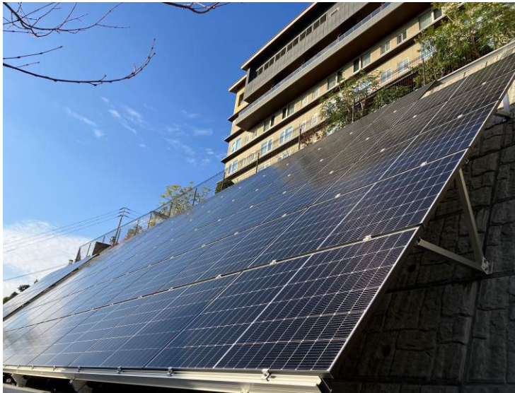
太陽光発電のパネルは160枚、総発電容量は65kW、蓄電池は9.5kW×2台
